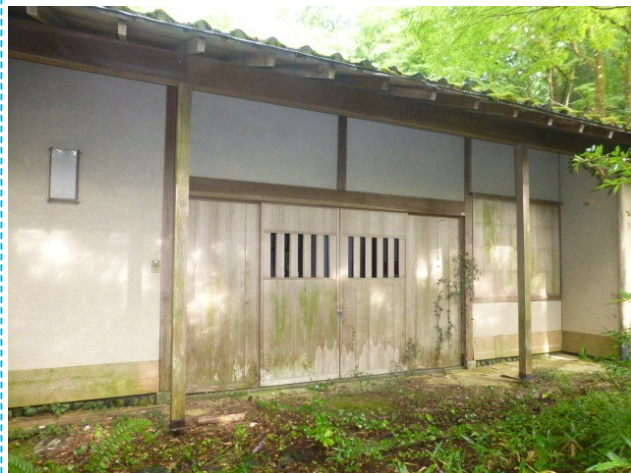
②建物（北側）
