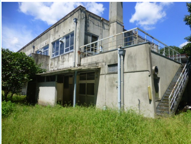
①建物（宿泊施設跡）
