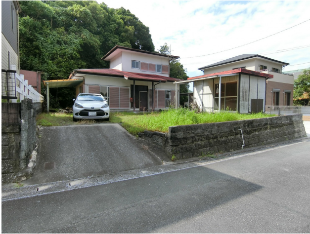
南側より撮影 現況写真
