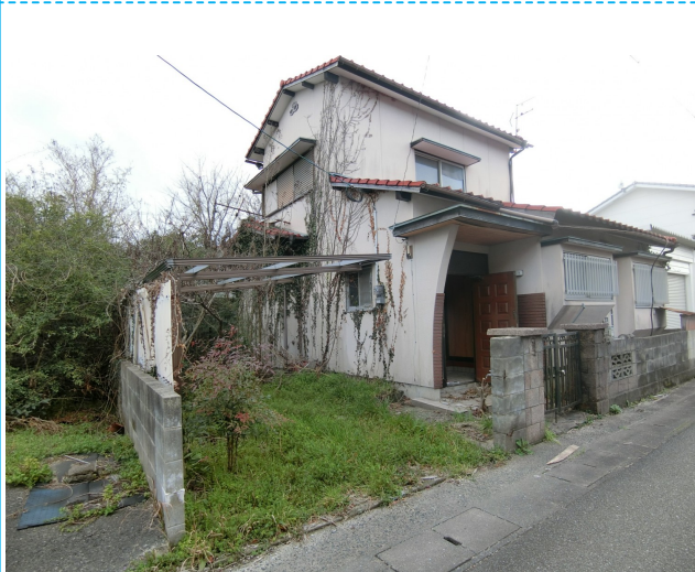
北東側より撮影
